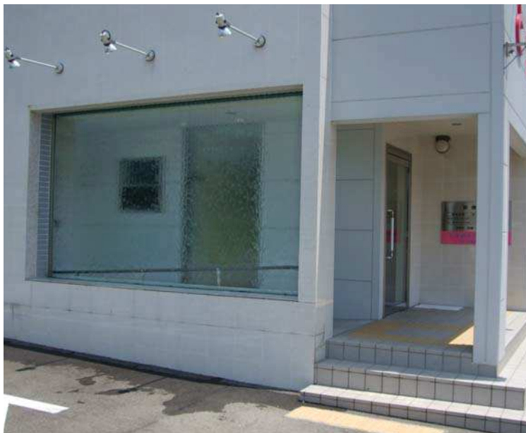
■事例18:建物屋外に水の流れを表現(栃木県:歯科)
